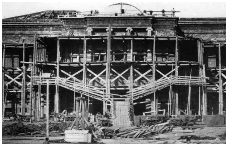
Строительство главного здания университета, 1883 г.
